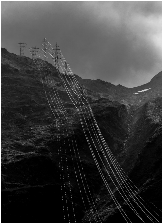
Hochspannungsleitung am Nufenenpass (Foto © Patrick Imhof)
